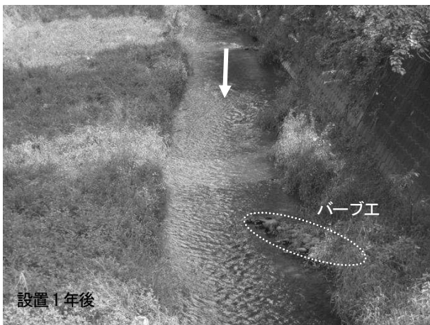
写真-4 精進川放水路（北海道）のバーブ工
