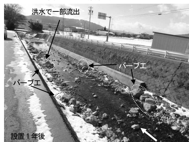
写真-7 梅谷川（岐阜県）のバーブ工
